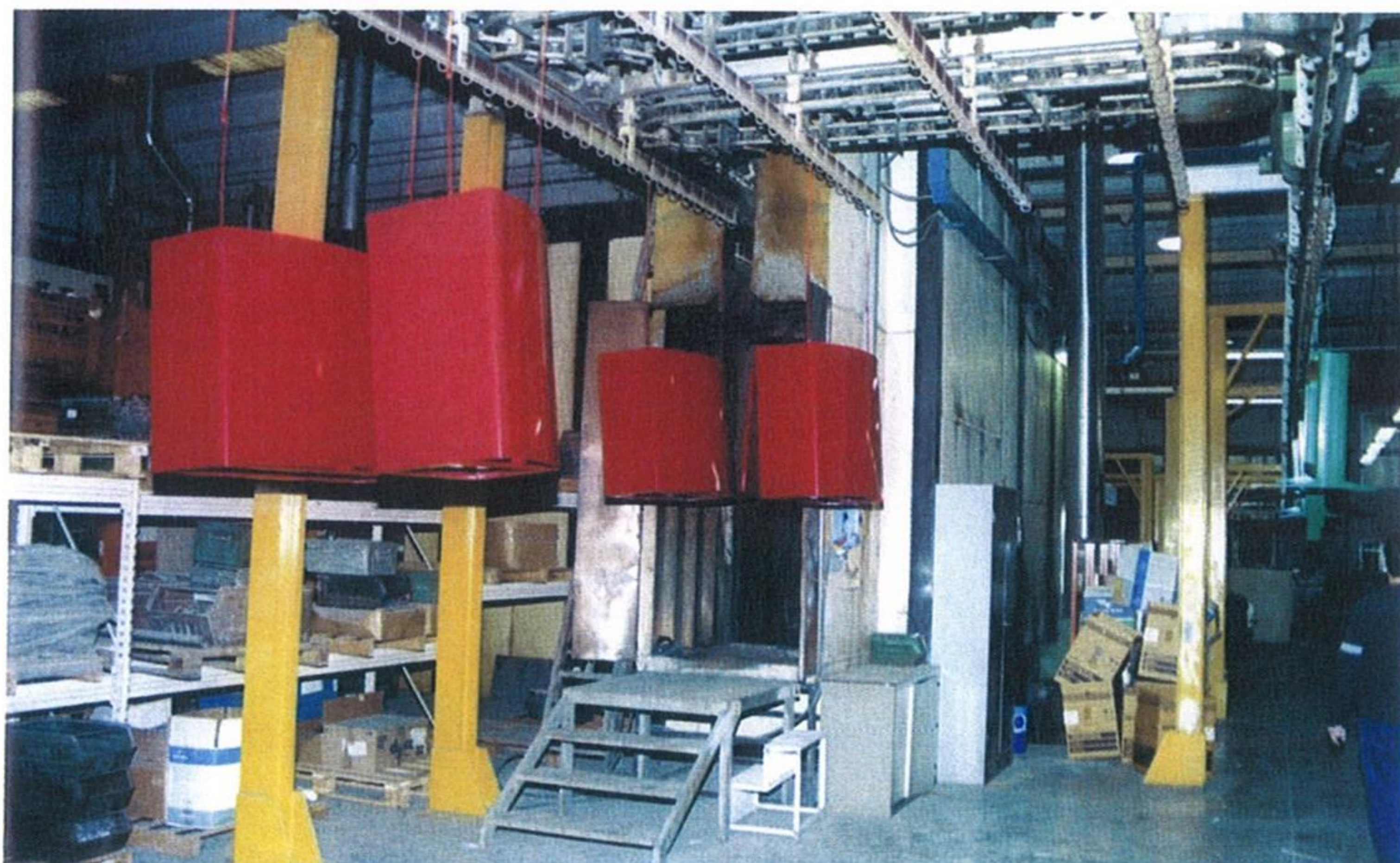
Fig. 10 - Particolare dell'uscita dei pezzi di supporto dei banchi di cassa dal forno di cottura delle polveri
